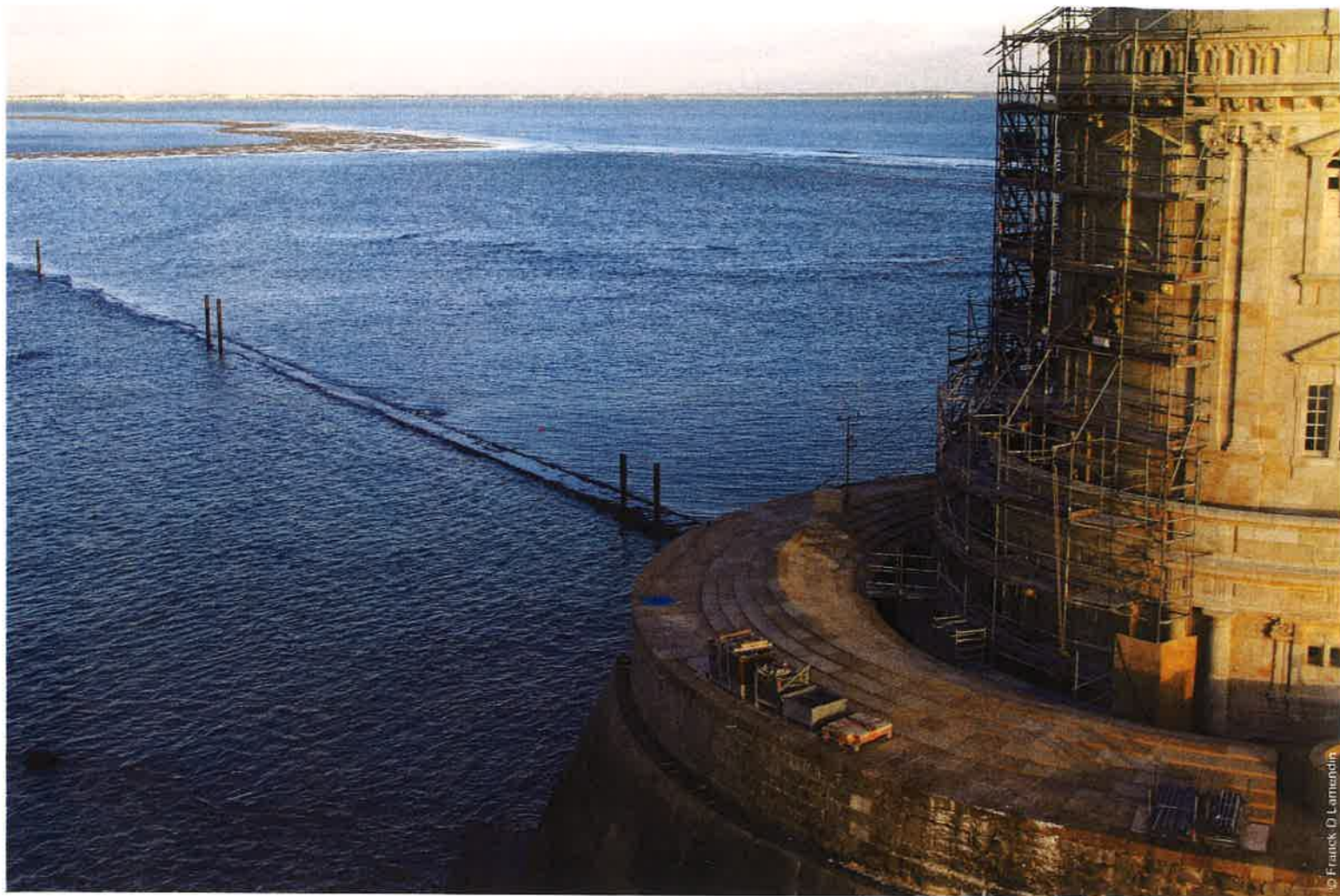
Les travaux de restauration partielle de la chaussée d'abordage Est (250 m environ) dite le « Peyrat » sont destinées à conforter les maçonneries malmenées par les courants de marée.
